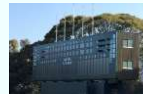
スコアボードの外部塗装
