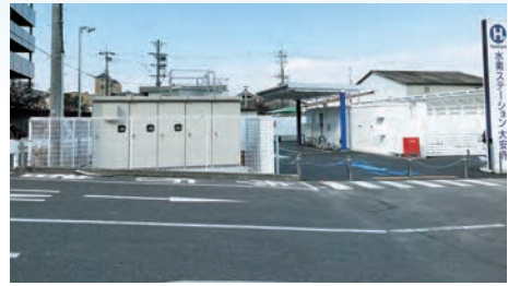
県内初の水素ステーション(奈良市大安寺)
