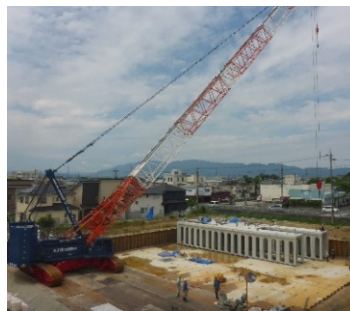
令和2年6月 貯留施設敷設工
