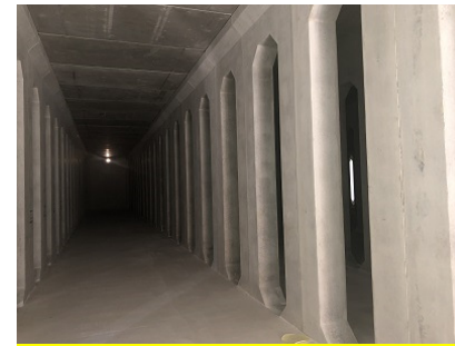
令和2年8月 貯留施設敷設完了
