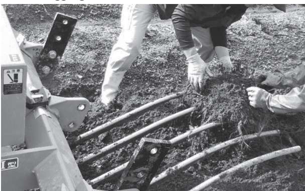
第3図 2名の補助員による掘り上げ作業支援の様子 Fig. 3. Supporting work for mechanized digging by two supporters
