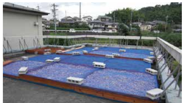
図1 敷設作業風景(上)と敷設後の外観(下)
