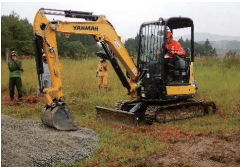
バックホウによる森林作業道開設の操作練習
