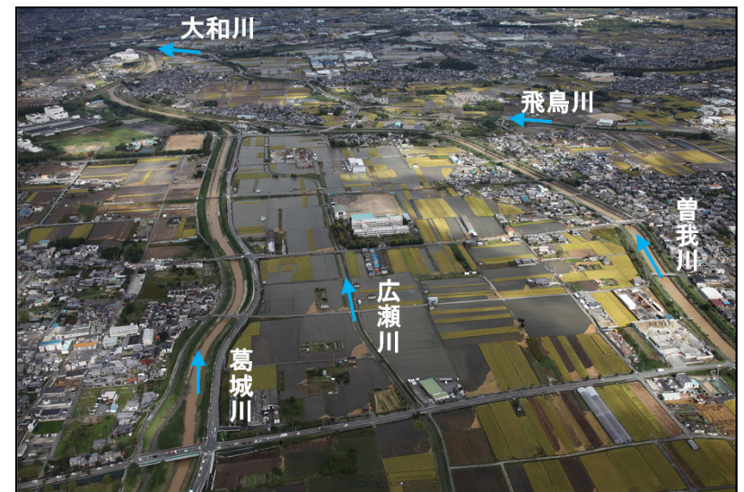
平成29年台風21号による被害状況 (広陵町大場地区 付近)
