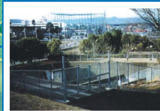
防災調節池 宅地造成等の市街地開発では河川への流出量が増大するため、防災調節池によって雨水を一時的に貯留し、流出を抑制します。
