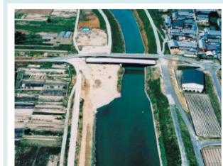
河川改修 川幅を広げたり、築堤を行うなど河川改修を進めています。
