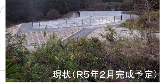
今住流域貯留施設 (御所市今住地区)
