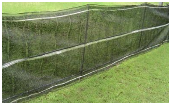
写真7 目隠しネット設置後
