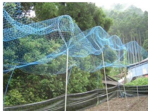
写真 11 ひさしの設置
