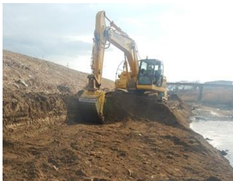
写真-2 ICT建設機械による施工状況
