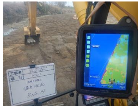
写真-3 ICT建設機械のモニター画面
