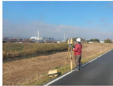
写真-1 地上型レーザースキャナーを用いた起工測量
