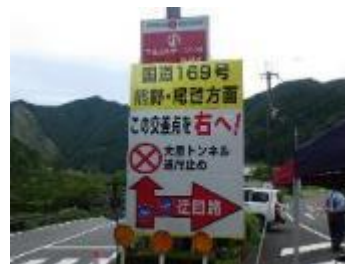
写真6 大型看板の設置
