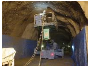
写真4 モルタル吹付
