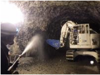
写真3 既設吹付モルタル撤去
