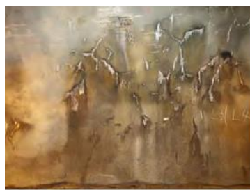
写真 2 漏水状況
