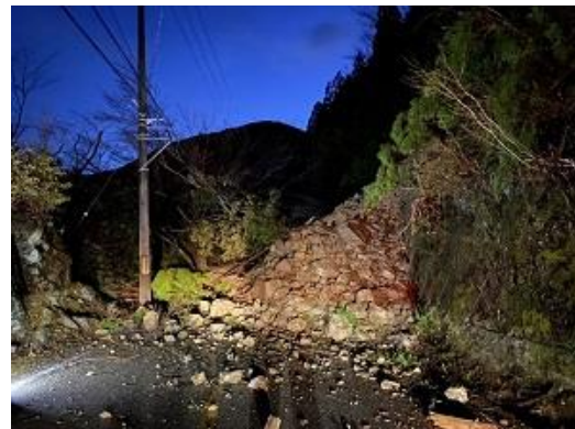
写真-1 国道168号崩土発生時
