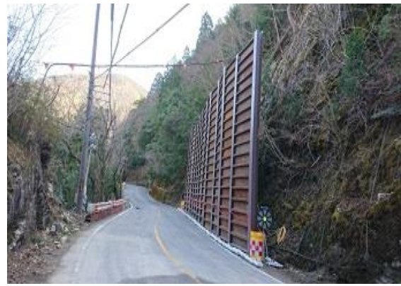
写真－3 崩土箇所応急対策完了時
