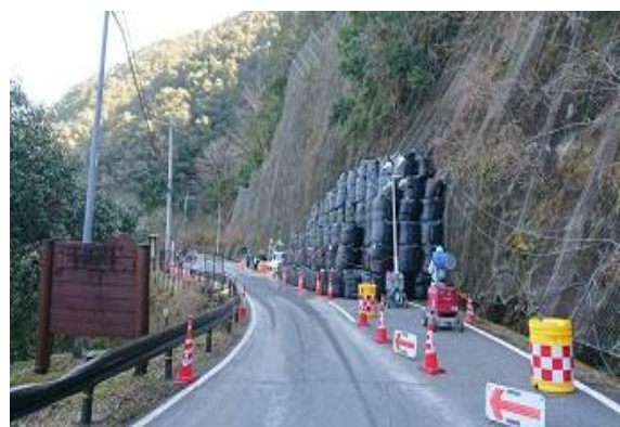
写真－4 落石箇所応急対策完了時
