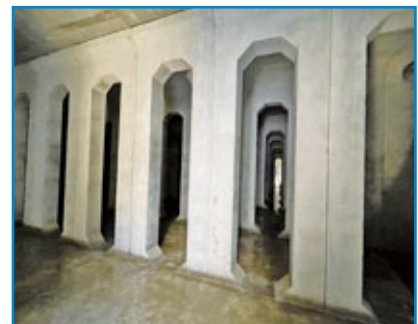
雨水貯留施設 内部
