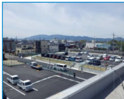
雨水貯留施設 外観
