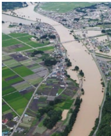
令和2年7月豪雨による浸水被害 (山形県大石町)
