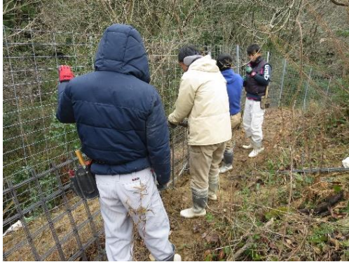
共同作業による 防護柵(ワイヤーメッシュ柵)の設置
