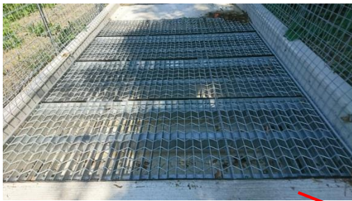
テキサスゲート シカ・イノシシの蹄が間隙に挟まるため、 圃場への侵入を防止
