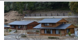
<十津川村復興住宅>
