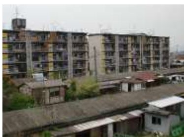
建替予定の老朽化した団地
