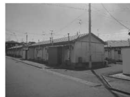
建替予定の老朽化した団地
