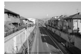
郊外戸建住宅地
