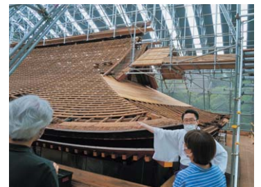
石上神宮 修理現場見学(6月より)
