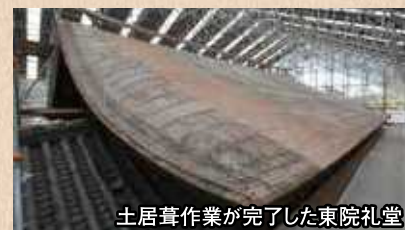
土居葺作業(杉の割板を使用)
