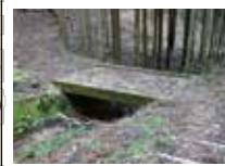
86 林道との交差点 砂防ダム工事により街道は失われている。現在は林道を左に少し上ってから谷治いの道を下る
