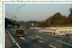
48 半焼橋 緑の道標から右側の橋を渡って、すぐ左折して線路沿いに坂道を下る。
