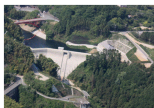
ダム (大門ダム)
