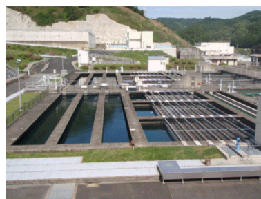
浄水場沈殿池 (桜井浄水場)
