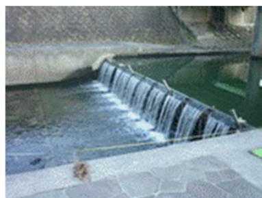
農業井堰用(改修後)
