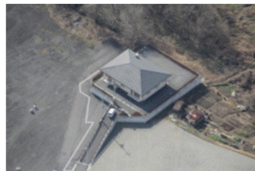
ポンプ場 (野原ポンプ場)
