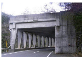
ロックシェッド (芦廻瀬洞門)
