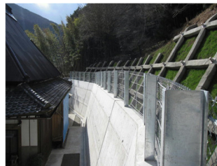
急傾斜地崩壊防止施設
