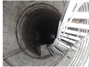
地すべり防止施設
