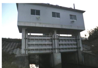
樋門 (小金打川逆流防止樋門)
