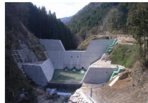
不透過型砂防堰堤のイメージ
