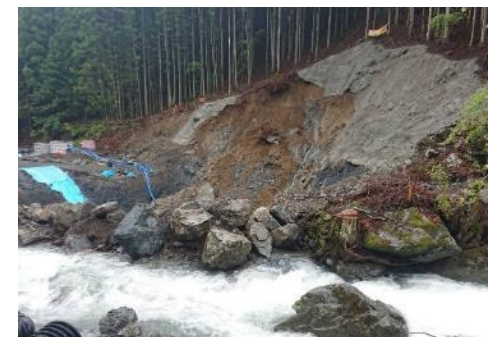
斜面崩壊(対策前)
