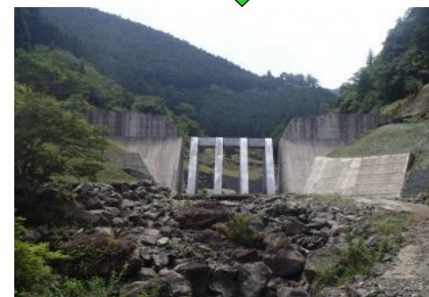
透過型砂防堰堤（泉谷川：3号砂防堰堤）
