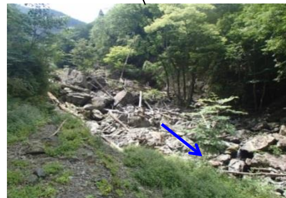
令和3年8月 現在も溪床に不安定土砂が厚く堆積
