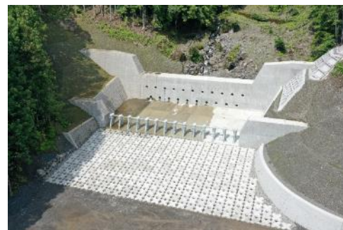
1号堰堤流木対策施設
