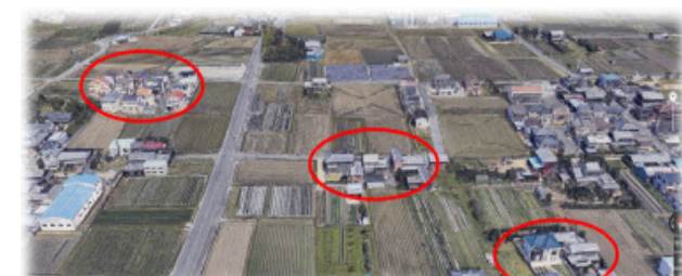
▲制度開始からしばらくの間は農地を含めた広範囲にわたる指定（集積率が低い）が行われたケースがあり、虫食いの開発が顕著
