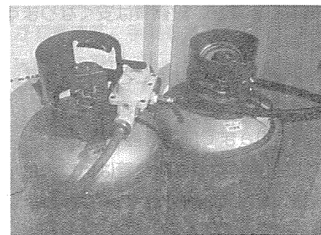
第15図 ボンベと自動切り替え弁
