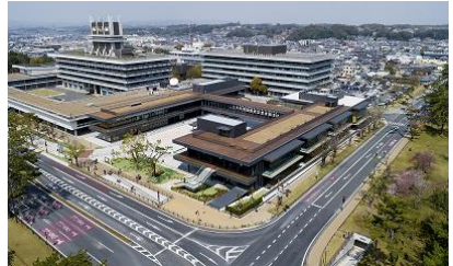
完成した奈良公園バスターミナル
