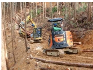
奈良型作業道
