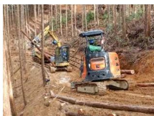
奈良型作業道
