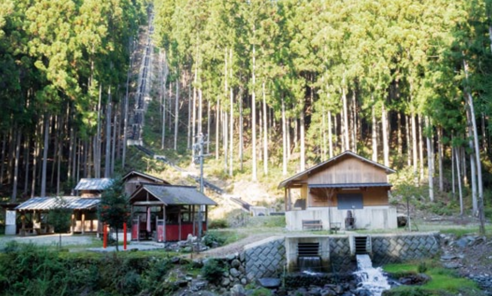
発電所建屋はヒノキ造りの山小屋風(右)。左奥斜面の黒い水圧管路を流れ落ちた水が発電機を回します
