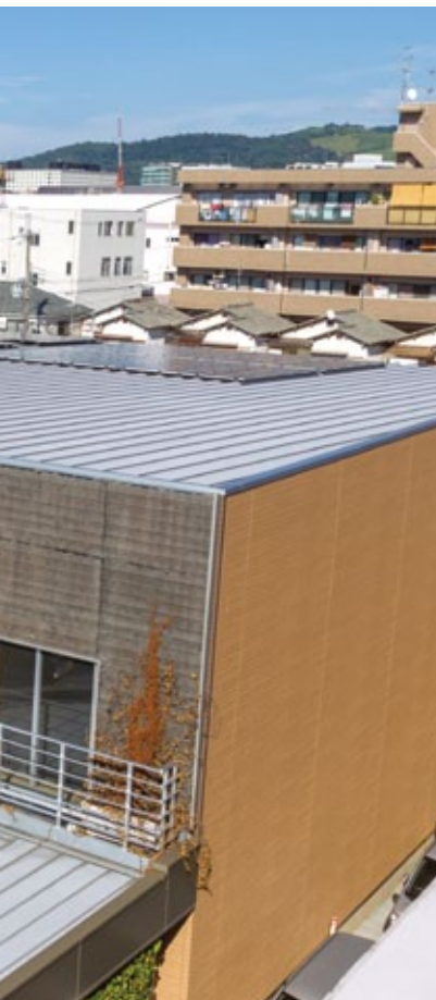
右が「恋の窪本部発電所」。
