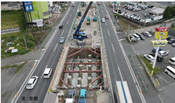
①(仮称)奈良IC~郡山下ツ道(下部工施工中)
