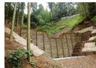
谷止工(公共事業への間伐材利用)
