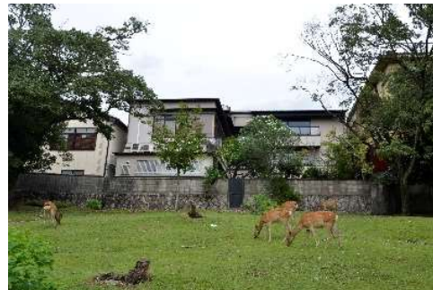
③東側スロープから見える民地建物
