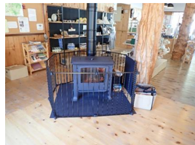
薪ストーブの設置 (天川村坪内)
