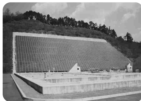
日本最大級の太陽光発電施設（県御所浄水場）
