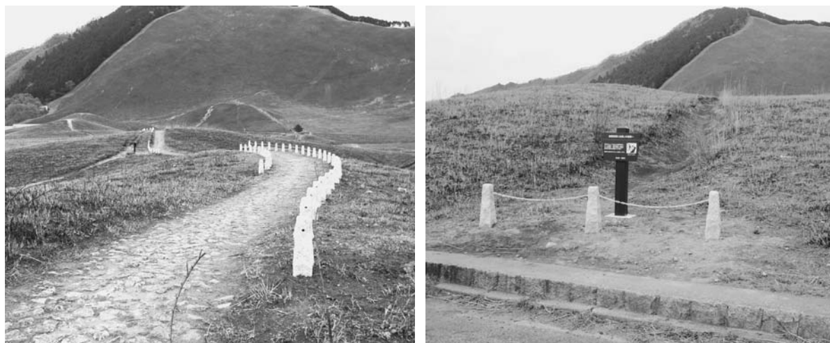
図2-4-1 自然公園の施設整備事例 (写真は曾爾高原園地歩道整備)
