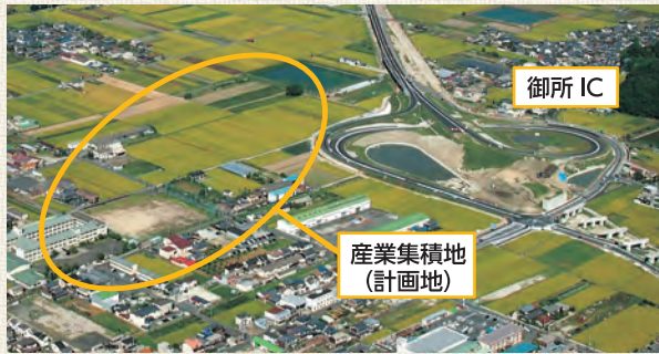
京奈和自動車道御所インターチェンジ周辺
