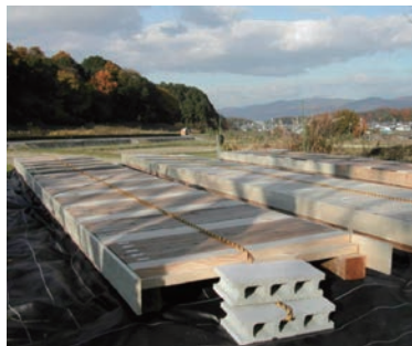
図4 ダブルレイヤー試験の設置状況
