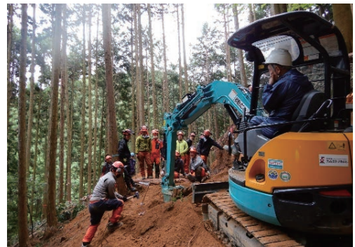
実習林での作業道作設の様子
