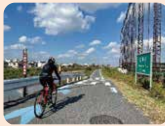
▲自転車道の整備 (京奈和自転車道佐保川区間)
