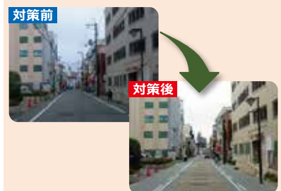
▲無電柱化(県道大和八木停車場線)
