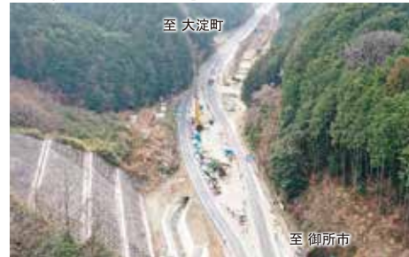
▲工事のようす
