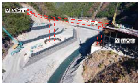
▲工事のようす
