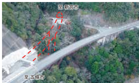
▲工事のようす
