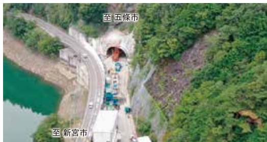
▲工事のようす
