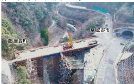
▲工事のようす
