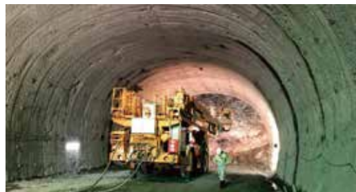
▲トンネル工事のようす
