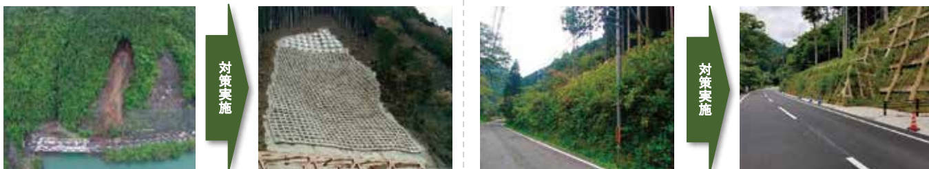
▲法面对策（国道168号 五條市大塔町小代）
