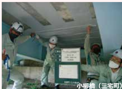
▲県が受託し、市町村職員が県職員と一緒に修繕工事をした橋梁
