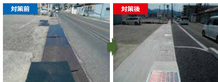
▲歩道設置(国道166号 葛城市尺土)
