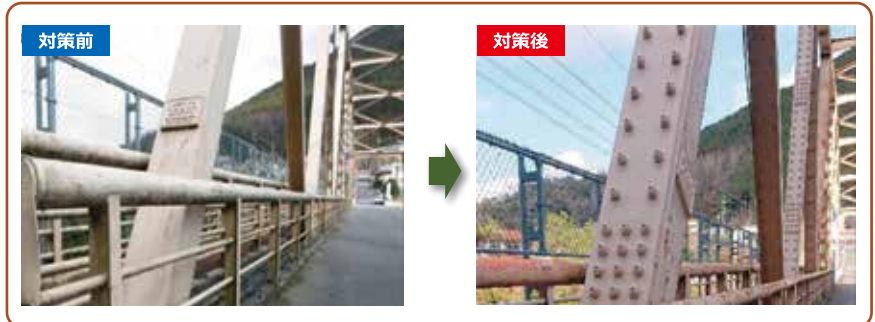
▲当て板補強による補修工事
