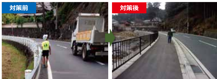
▲歩道設置(国道369号 宇陀市榛原檜牧)
