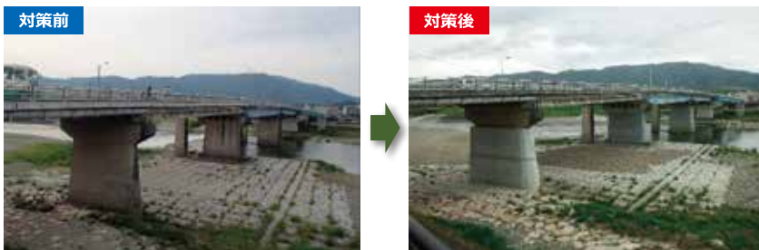
▲橋脚巻立て工による耐震補強工事（国道168号 大川橋）
