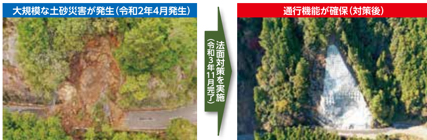
▲法面对策による通行機能の確保（国道169号 下北山村上池原）
