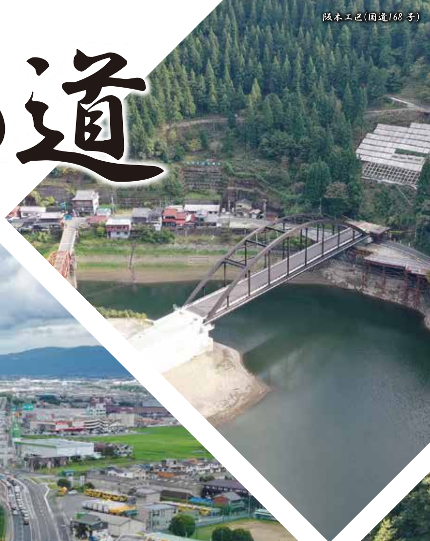
奈良和自動車道(橿原北IC～橿原湯田ICの工事状況)
