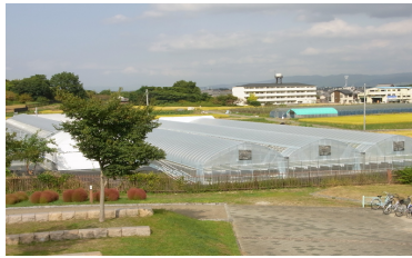
寺戸地区で新たに整備されたイチゴ栽培施設
