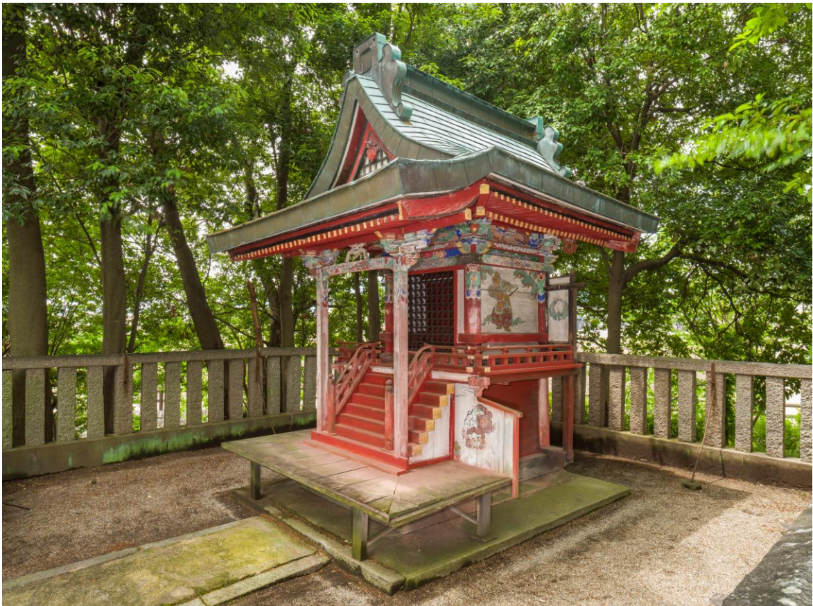
正側面全景、東北より
