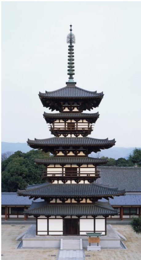
薬師寺東塔全景、西より
