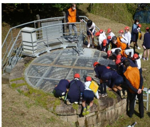
【集水井の現物を確認】
