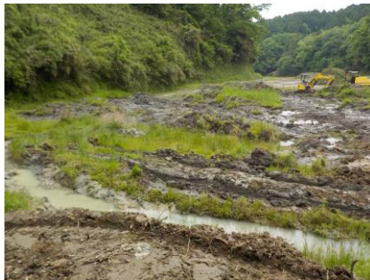
軟弱地盤の状況
