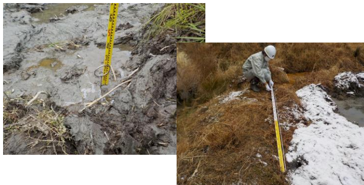
軟弱地盤の深さの確認状況
