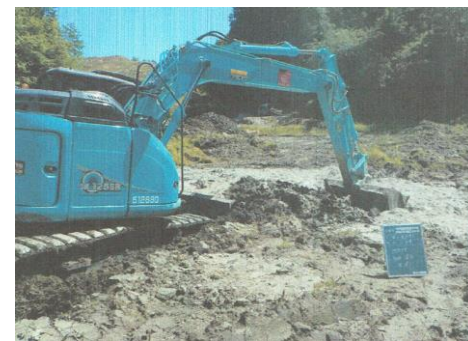
改良の施工状況
