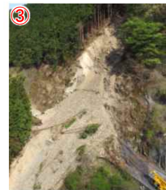
大規模法面崩壊（五條市西吉野町西野地内）
