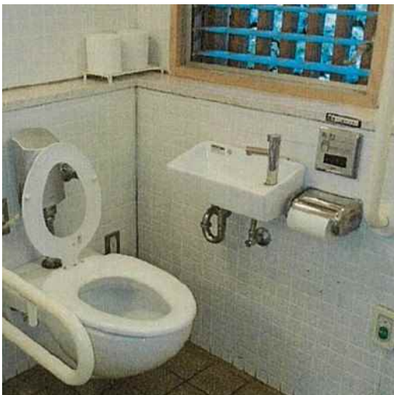
身障者便所（施工前）
