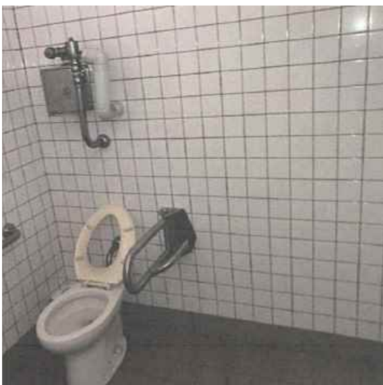
身障者便所 (施工前)
