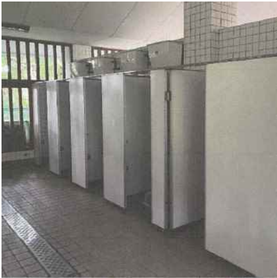
トイレブース (施工前)
