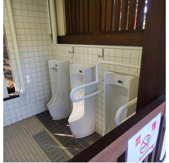
小便器（施工後）
