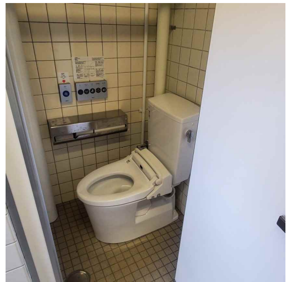
大便器（施工後）
