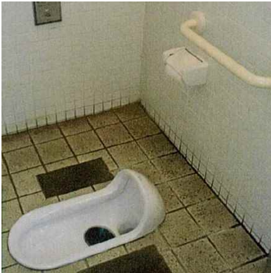
大便器（施工前）
