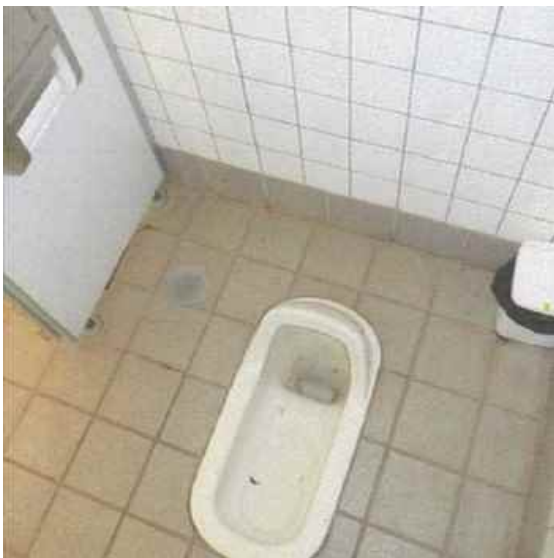
大便器 (施工前)
