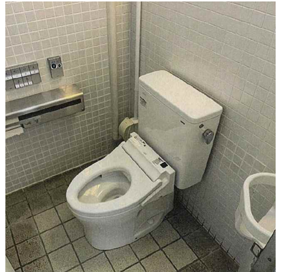
大便器（施工後）
