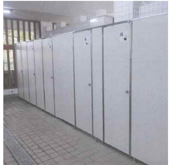
トイレブース (施工後)
