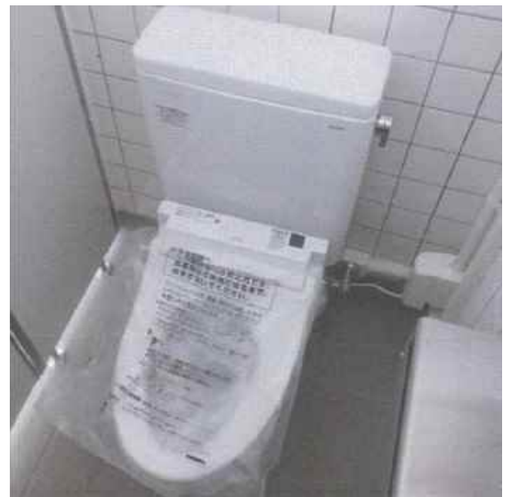
大便器 (施工後)
