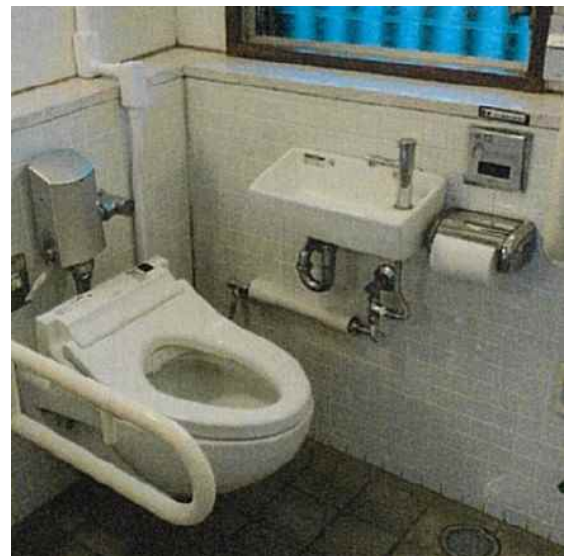
身障者便所（施工後）
