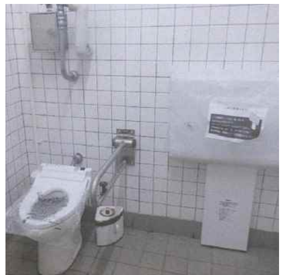
身障者便所 (施工後)
