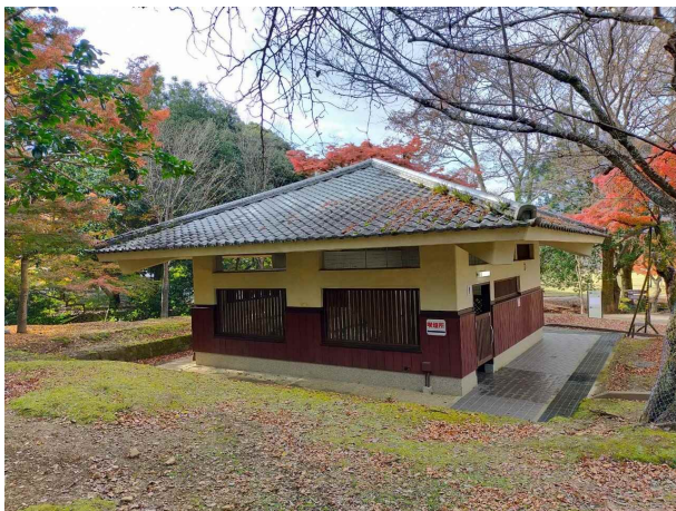
北東面（施工前）
