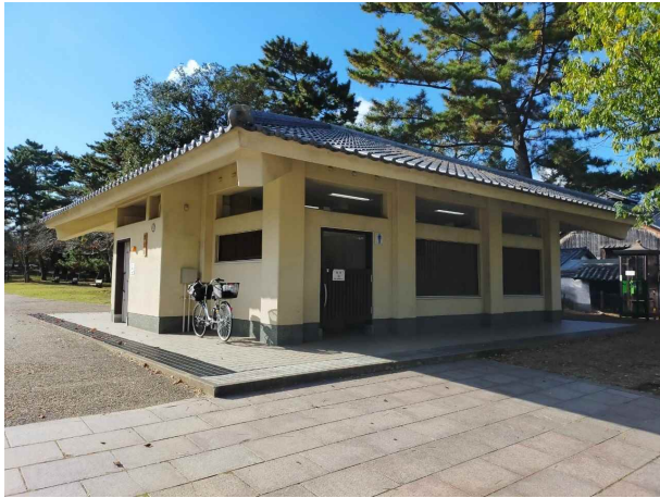
北東面（施工前）
