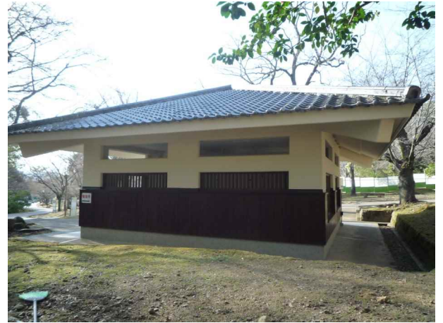
南東面（施工後）
