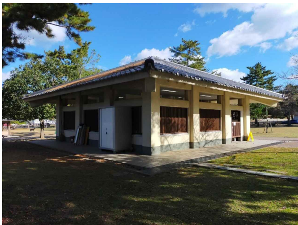
南西面（施工前）
