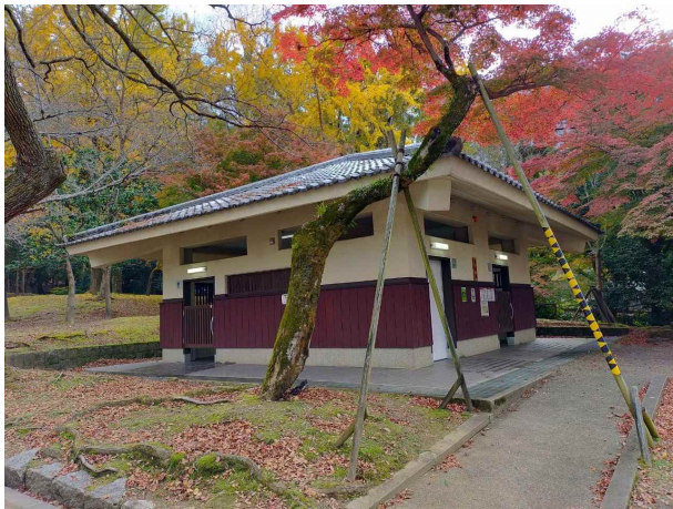
北西面（施工前）
