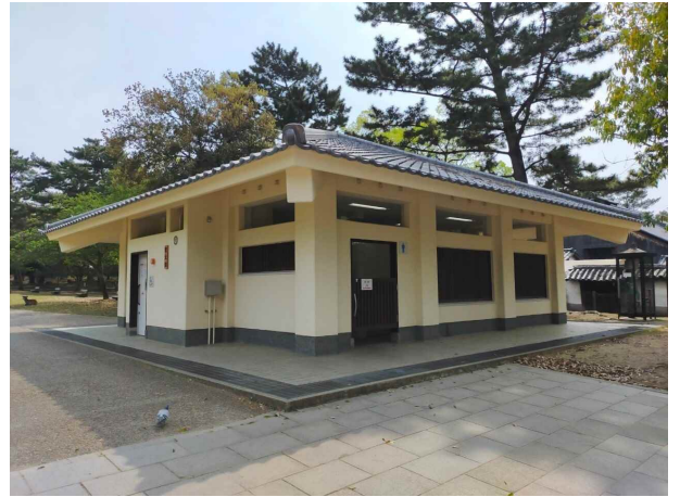
北東面（施工後）
