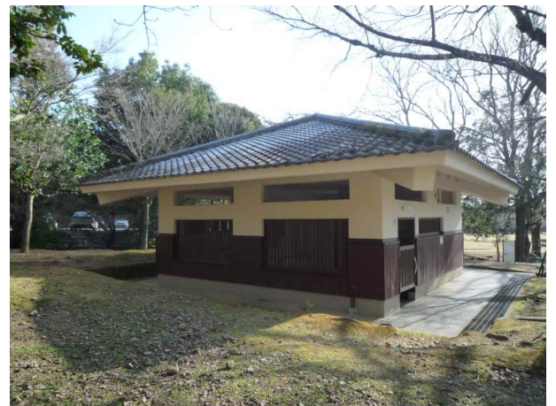
北東面（施工後）
