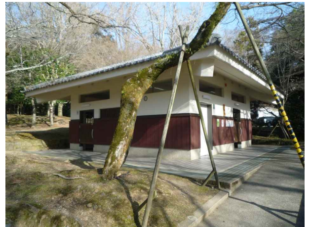
北西面（施工後）
