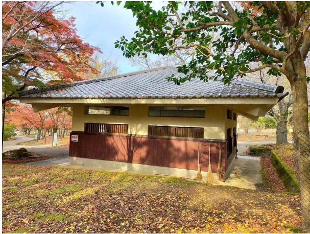
南東面（施工前）
