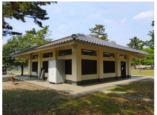
南西面（施工後）
