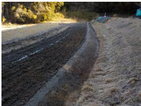
▲横手水路の施工状況
