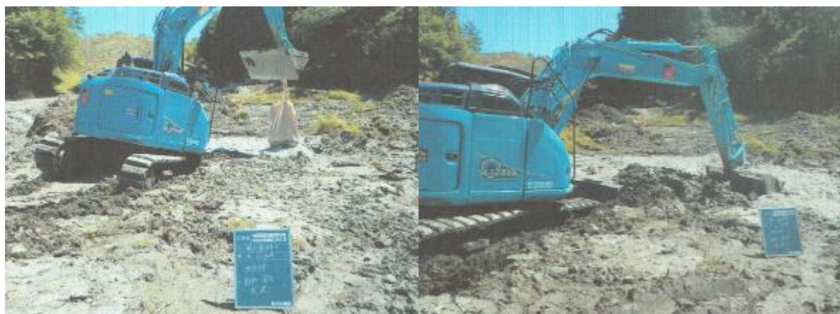
▲セメント系固化材を基盤土と攪拌
