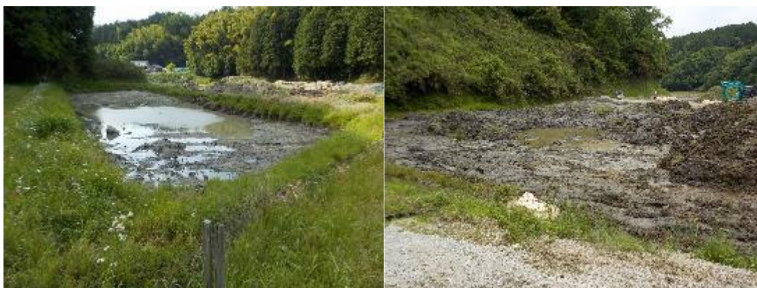
▲工事施工箇所の軟弱地盤ほ場
