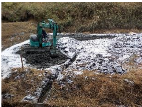
▲暗渠排水の施工状況
